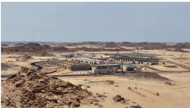
Figura 5: Progreso de las obras de construcción de “The Line”, la ciudad lineal en Arabia Saudí. Fuente: NEOM
