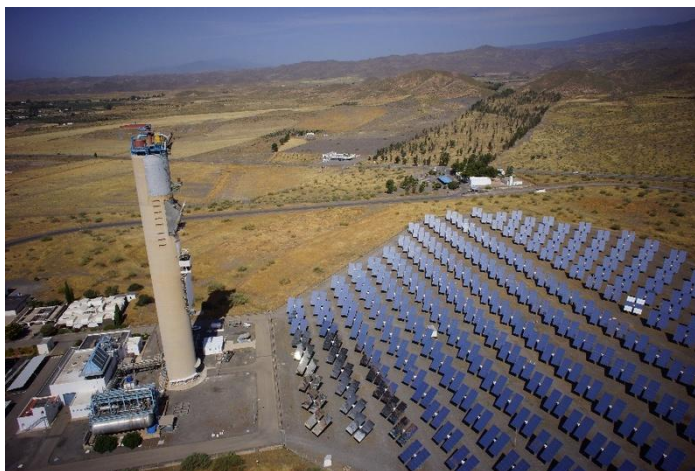
Figura 1: Planta Solar de Almería PAS-CIEMAT. Fuente: Ciemat
